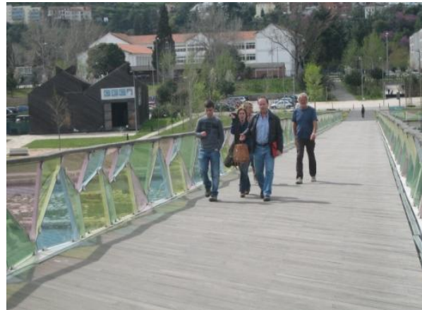
Ponte Pedonal sobre o Mondego - Coimbra
