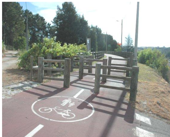
EcoPista Dão- Viseu/Sta Comba
