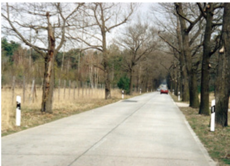
FIGURA 8 Estrada com limite de velocidade de 70 km/h devido à proximidade de obstáculos perigosos da faixa de rodagem (Alemanha)
