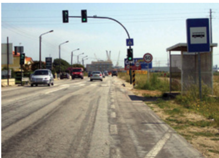
FIGURA 31 Passagem de peões com sinalização luminosa de controlo de tráfego e detector de velocidades excessivas.
