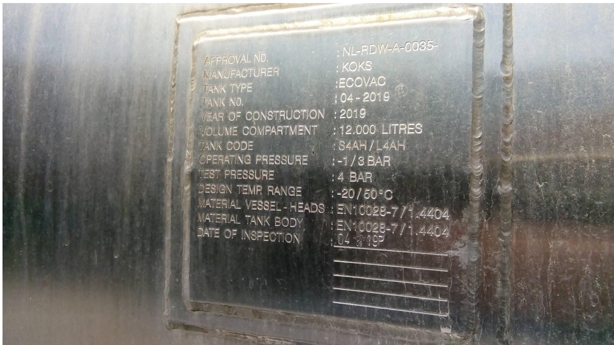
Foto de chapa de fabrico (Nº aprovação NL-RDW-0035-).
