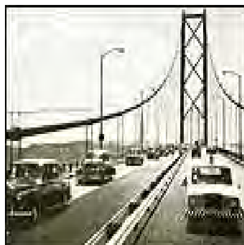
Figura 3 – Ponte sobre o rio Tejo, 1966
