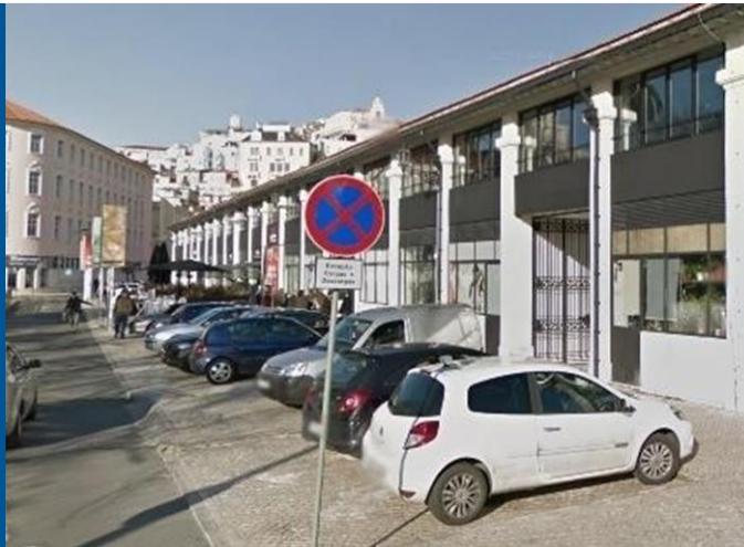
Fonte: Perform Energia
