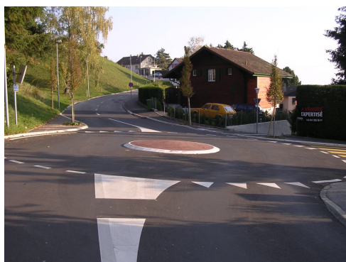
Figura 43 – Exemplo de mini-rotunda, Lutry, Suíça
