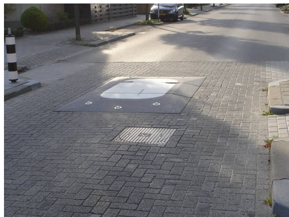
Figura 30 - Deflexão vertical quadrilátera, Zwole, Holanda
