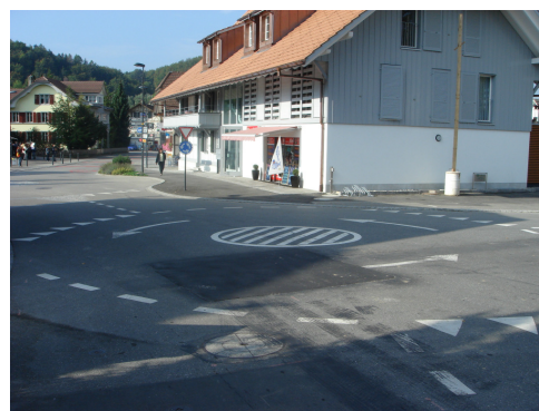
Figura 44 – Exemplo de mini-rotunda, Neunegg, Suíça
