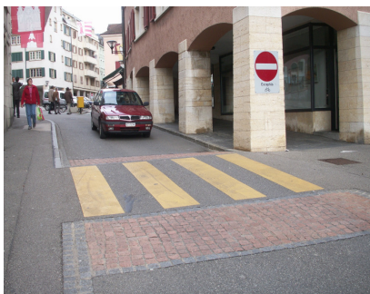
Figura 27 – Plataforma sobrelevada trapezoidal com atravessamento pedonal, Genebra, Suíça
