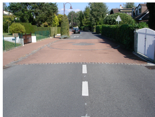
Figura 26 – Pavimento assimétrico, Lausanne, Suíça
