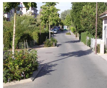
Figura 41 – Exemplo de efeito de gincana criado através da implementação unilateral alternada de estreitamentos laterais de via, Lonay, Suíça
