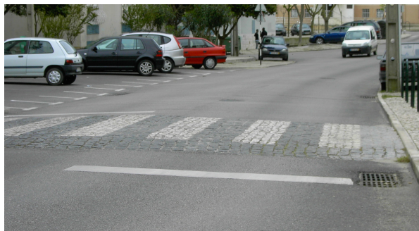
Figura 33 – Plataforma trapezoidal, Almada
