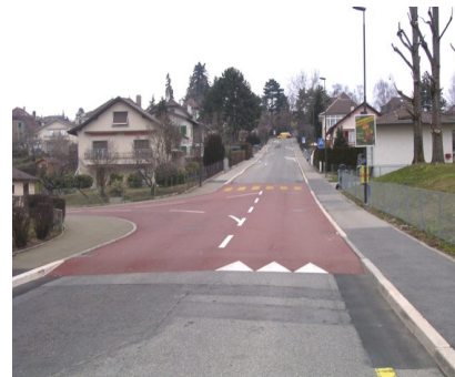
Figura 28 – Intersecção sobrelevada trapezoidal com atravessamento pedonal, Bussigny, Suíça
