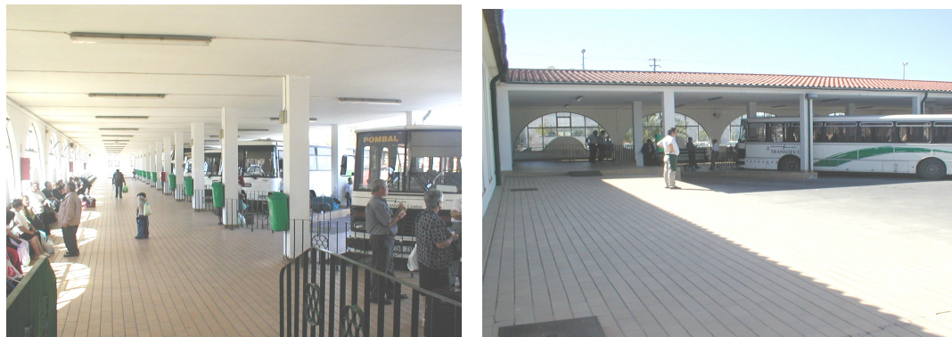
Figura 8 – ECC de Pombal (Fonte: IMTT, I.P.)
